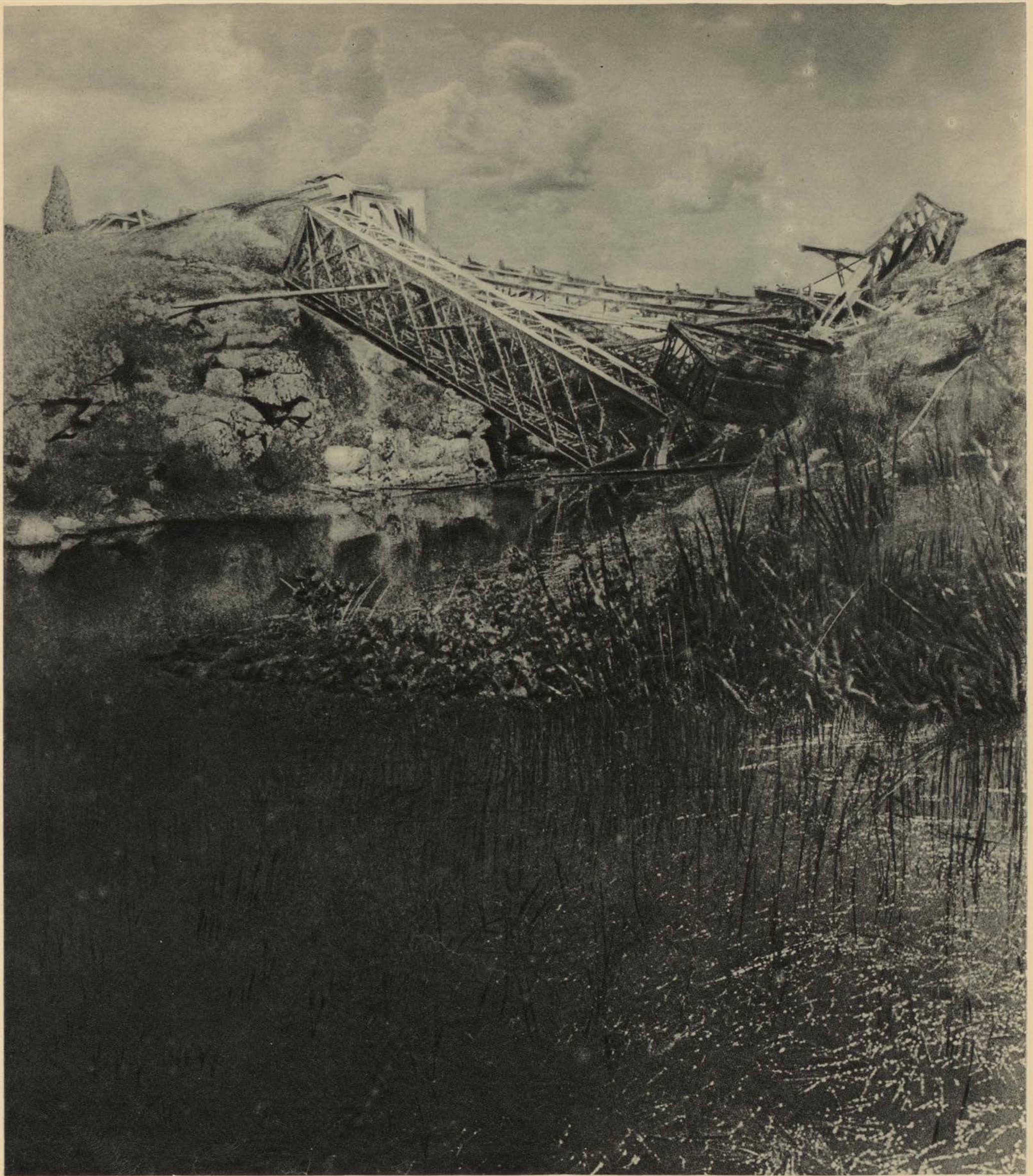
Разрушенный белый мост через реку Лиску
