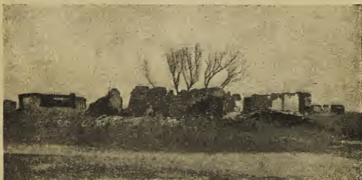
Хутор Ярошкин у ст. Сальково, разрушенный белыми.
