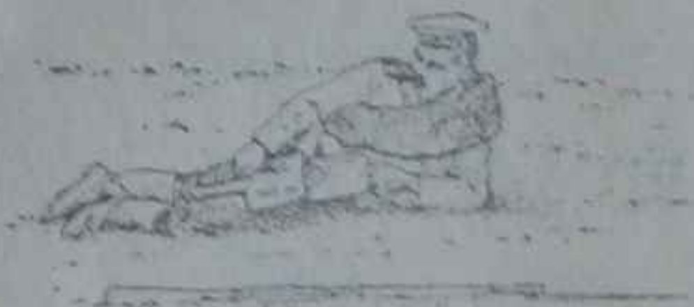
Подготовка къ отрывкѣ окопа.
