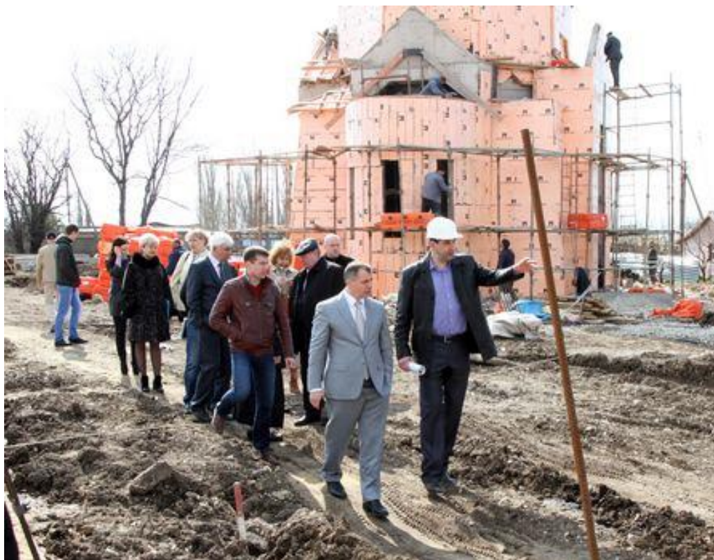
Председатель Государственного Совета В.А. Константинов курирует строительство Мемориала жертвам фашистской оккупации Крыма 1941-1944 гг. «Концлагерь «Красный»
